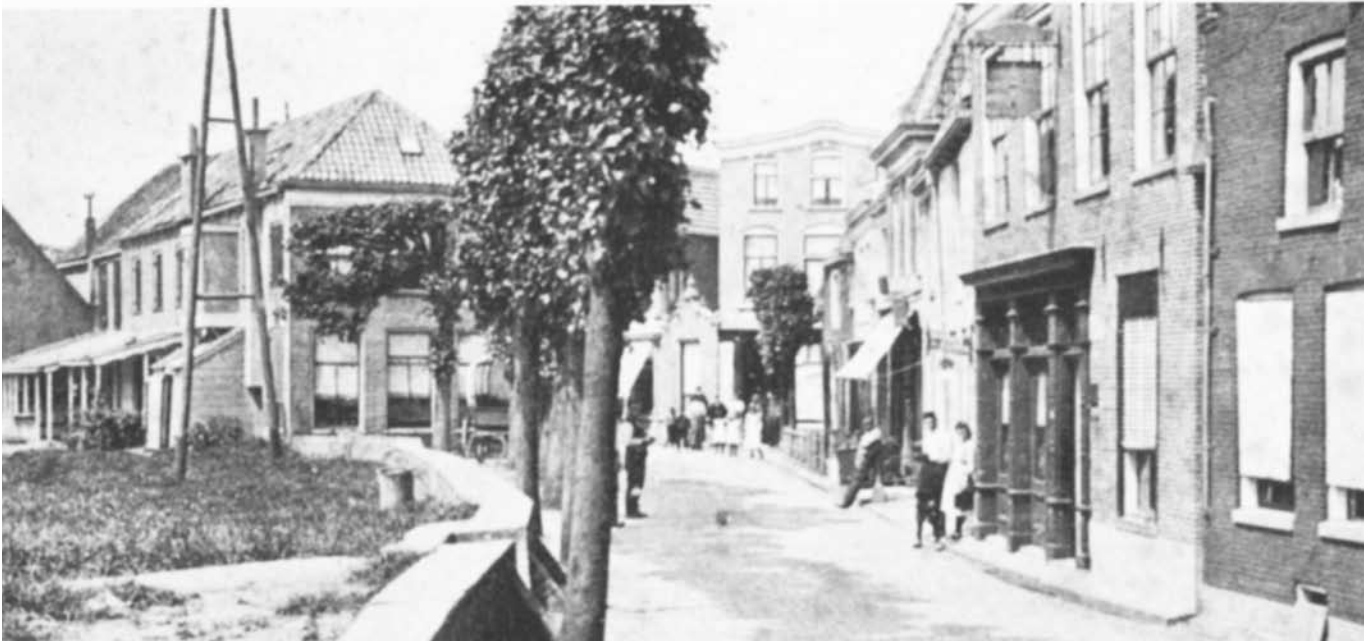
Foto van "De Dijk" in 1909. Links is de muur aan de kant van het Zwartewater zichtbaar.
